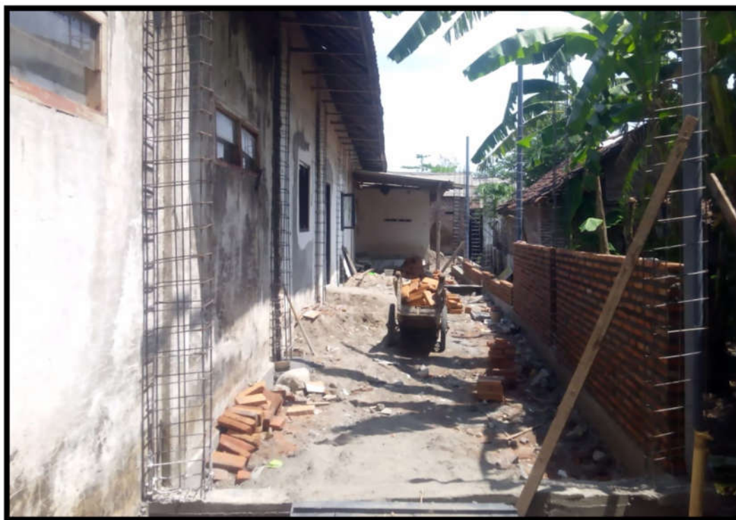
Gambar 5. Pembangunan gedung baru Perpustakaan Desa Podoroto
