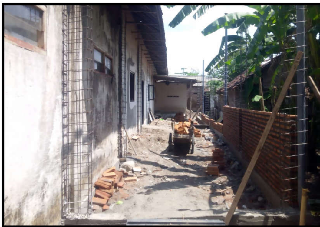
Gambar 5. Pembangunan gedung baru Perpustakaan Desa Podoroto
