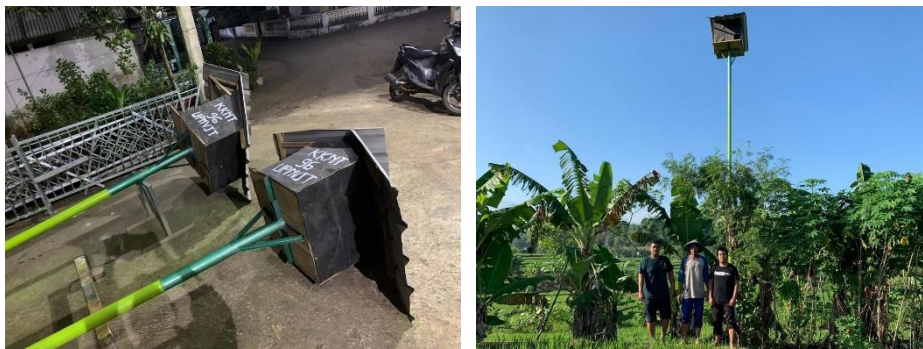
Gambar 5. Pemasangan Rubuha yang Sudah Siap
