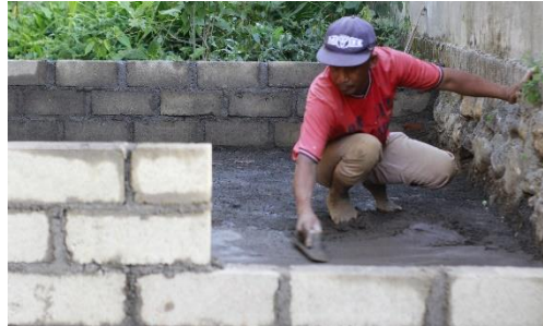
Gambar 2. Proses pembuatan tempat penampung pupuk
