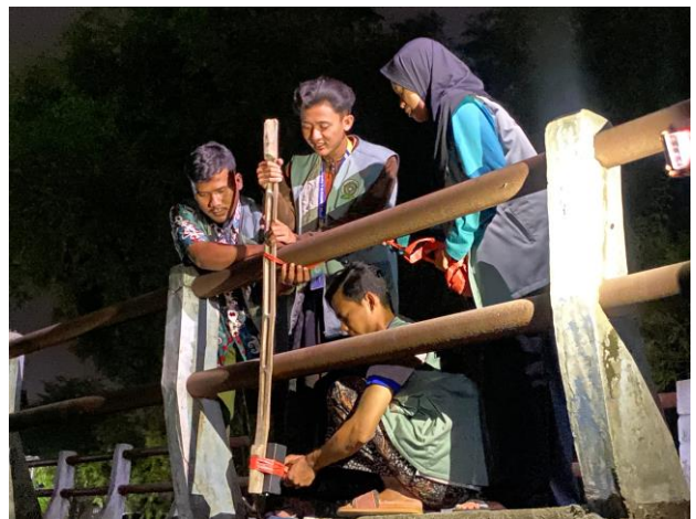
Gambar 3 Pemasangan Alat Detektor Banjir
